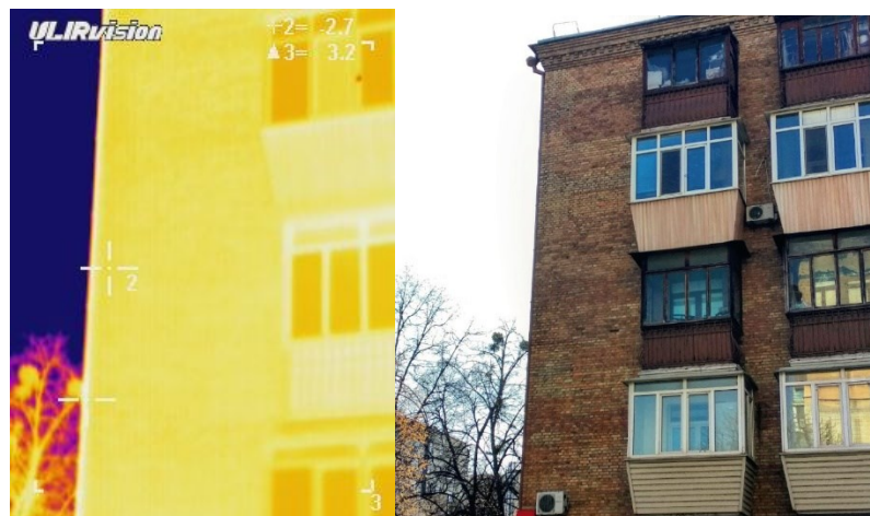
Рисунок 2 – Тепловізійна зйомка фасаду житлової будівлі
