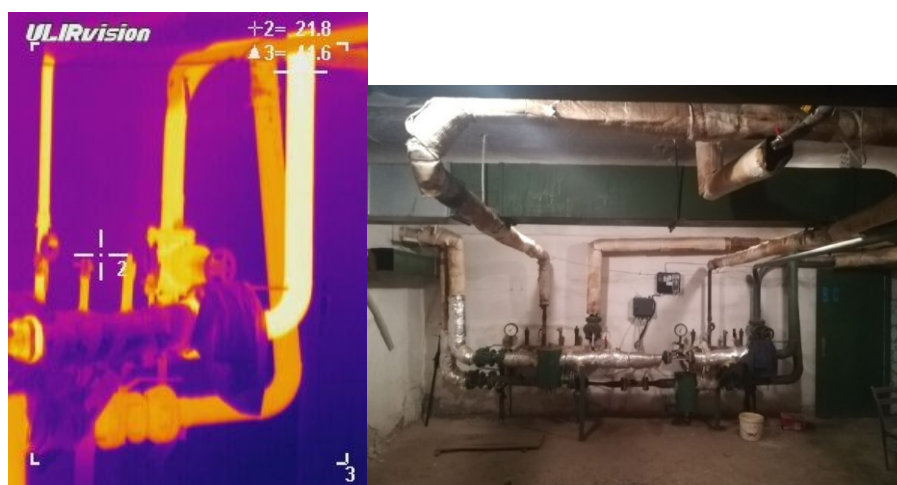
Рисунок 2 – Тепловізійна зйомка теплового пункту будинку
